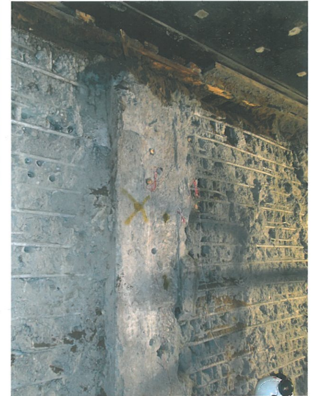
5 Situatie vóór ontsteking, na verwijderen betondekking
